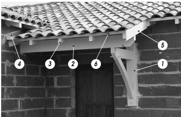
Fig. 23 Exemple de réalisation 1. console, 2. panne, 3. chevron, 4. bande de zinc pour récupérer l'eau de pluie et assurer l'étanchéité le long du mur, 5. planche de rive, 6. chanlatte
